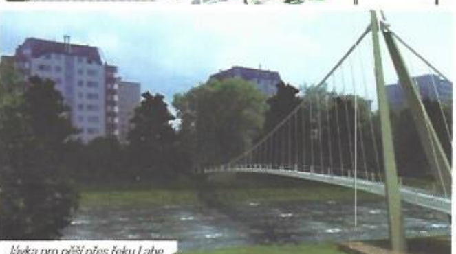
lávka pro pěší přes řeku Labe
